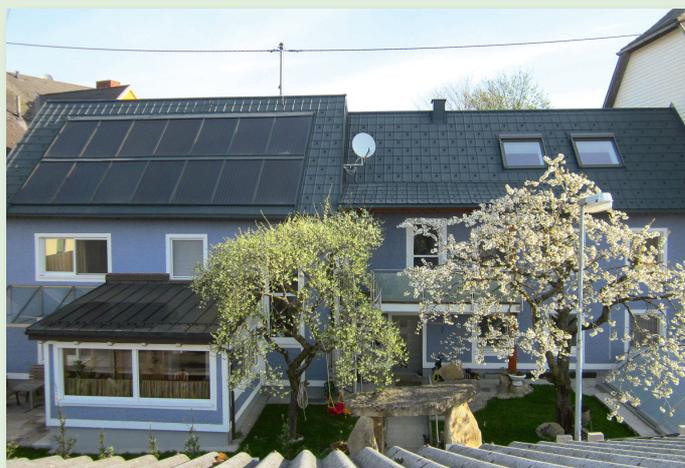
Solaranlage installiert. Mit einem Pufferspeicher von 3.000 l mit Schichtlademodul und einem zusätzlichen Warmwasserboiler von 500l wird damit das ganze Haus (zwei Wohntage) mit Warmwasser versorgt und die Heizung unterstützt.
